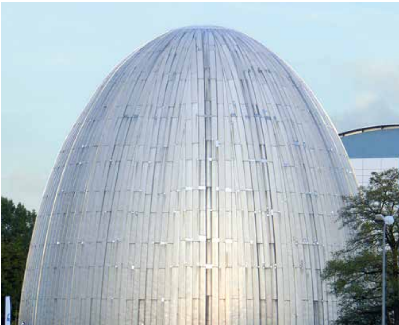
Das »Atomei« in Garching: Der Forschungsreaktor München (FRM) wurde am 31. Oktober 1957 als erste kerntechnische Anlage in Deutschland in Betrieb genommen.
